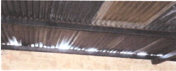
Foto1: CUBIERTA DE LAMINA
