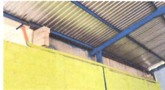
Foto 4: CANALES Y BAJADAS DE AGUA PLUVIAL
