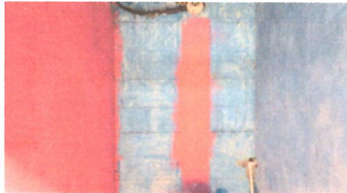
Foto 3: PINTURA EN MUROS INTERIOR Y EXTERIOR
