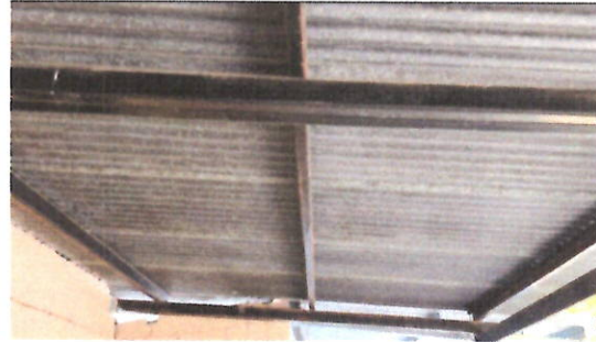
Foto 2: ESTRUCTURA DE TECHO
